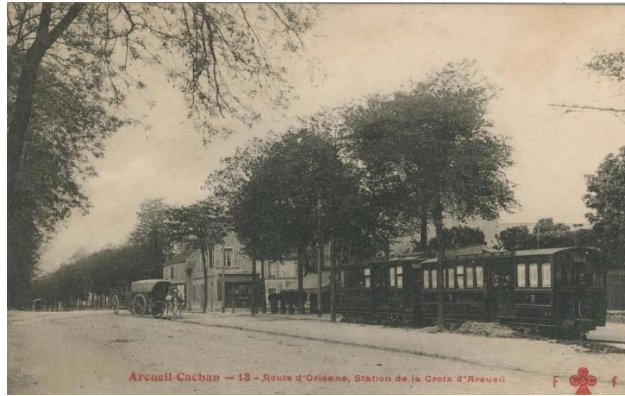
La voie du tramway et du train Paris-Arpajon, à Arcueil, sur la route d'Orléans
